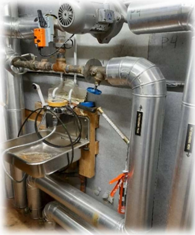
Kuva 4. 5. ja 6. Ilmastointilaitteet, turvakytkin ja laitteiden ohjaus lämmönjakokeskuksessa
