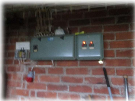
Kuva 3 ja 4. Ilmastointilaitteet, turvakytin ja laitteiden ohjaus lämmönjakuhuoneessa.
