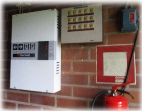
Kuva 1. Turvalokeskus lämmönjakuhuoneessa Kuva 2. Sähköpääkeskus sakastissa
