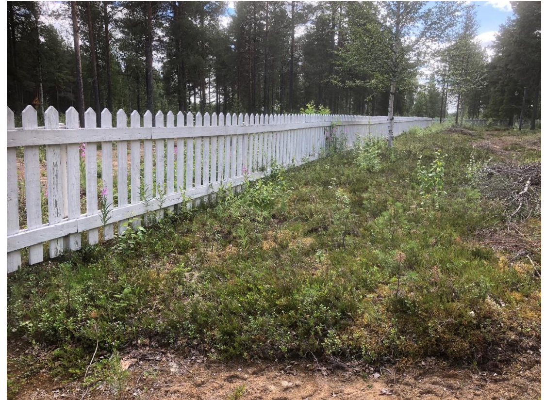
Hautausmaata ympäröivä puuaita. Aitaan on helppo rakentaa portti, josta saataisiin suora kulkuyhteys parkkipaikalta uurnahautausmaalle ja muistelupaikalle.
