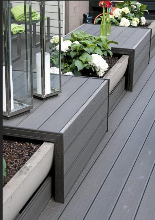
Komposiitti laudasta tehdään penkit/tasot muuratun penkin päälle. Taso toimii istuimena ja lyhdyille tasona. Kesällä kesäkukat ja talveksi kanervat penkkeihin.
