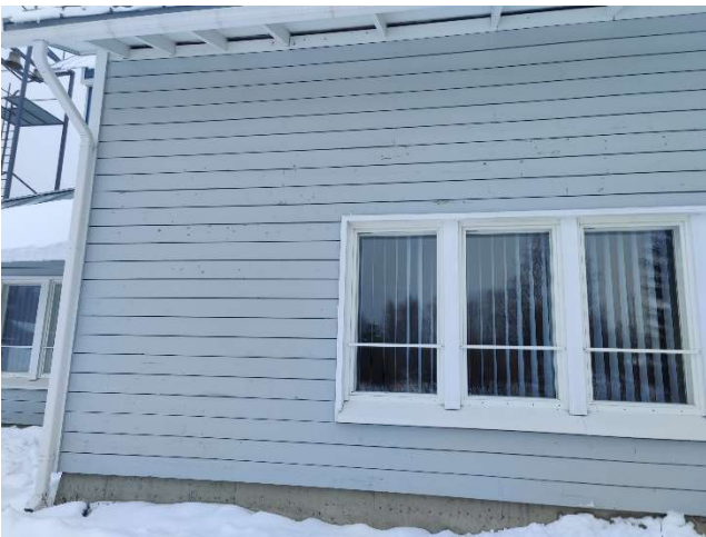
Kuva 3. julkisivun huoltomaalaus ajankohtaista
