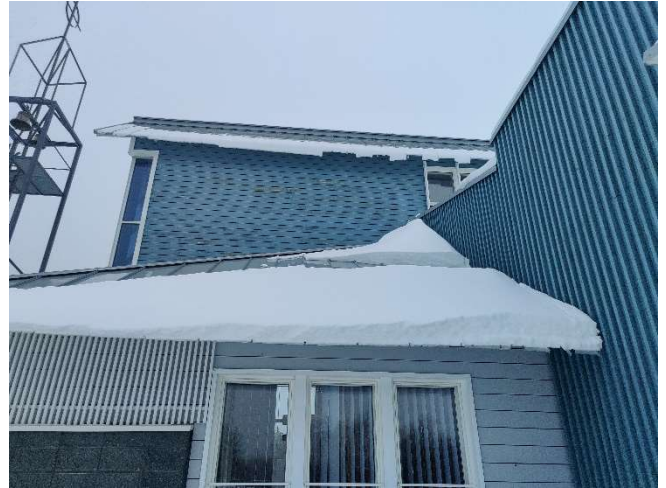
Kuva 2. julkisivun huoltomaalaus ajankohtaista
